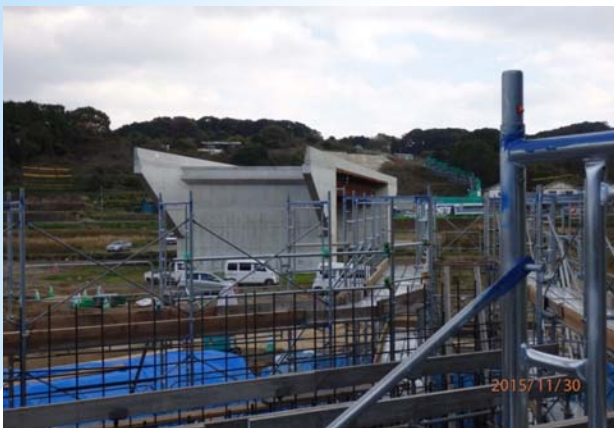
《諫早外環状線(大型函渠)現場》
