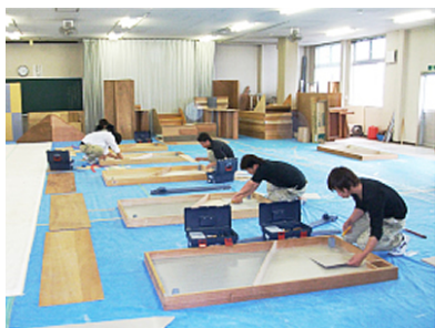
岩野職業訓練学園内の実技室でタイル張りの訓練を行う若手技能者
