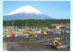
鉄骨躯体教材
