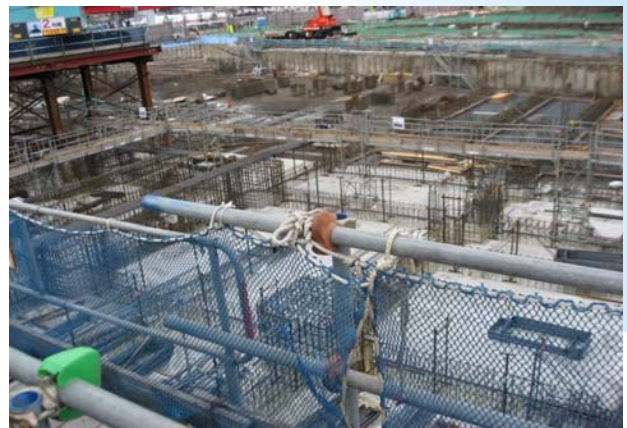
《長崎県庁舎(行政棟)現場》
