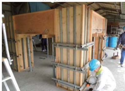
型枠工事実習用ユニット
